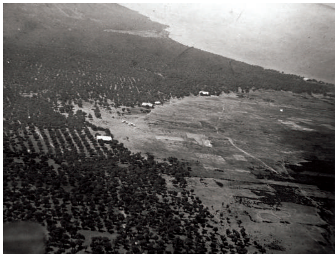
Αεροφωτογραφία της βάσης στο Καζαβήτι. Τα υπόστεγα των αεροπλάνων είναι σημμένα σε ημικυκλική διάταξη στις παρυφές των ελαιώνων. Το πλέον απομακρυσμένο είναι το υπόστεγο των υδροπλάνων.
